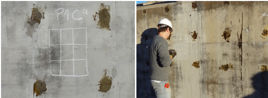
Figura 9: Detalhe do grid utilizado e da execução do ensaio de esclerometria.
