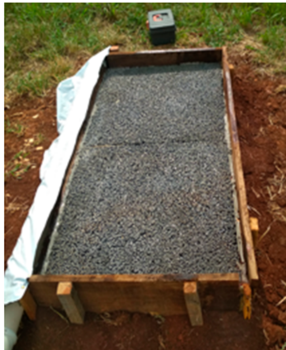
Figura 9. Modelo de pavimento de concreto permeável instalado
