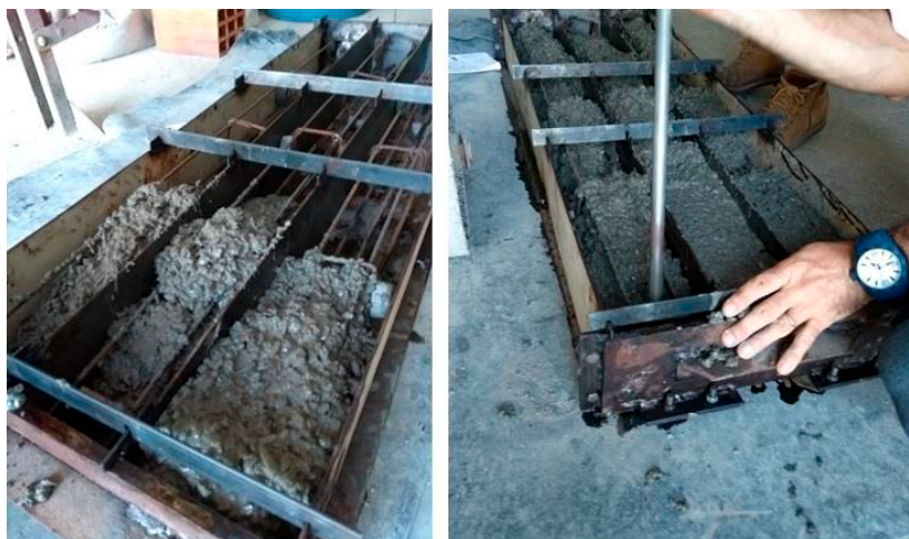
Figura 3. Concretagem das vigas
