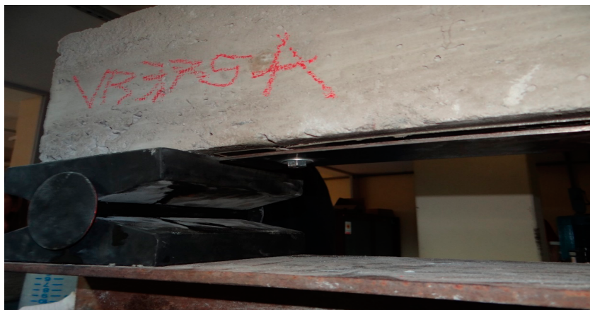
Figura 8 – Descolamento da chapa de aço da viga VR3,75A
