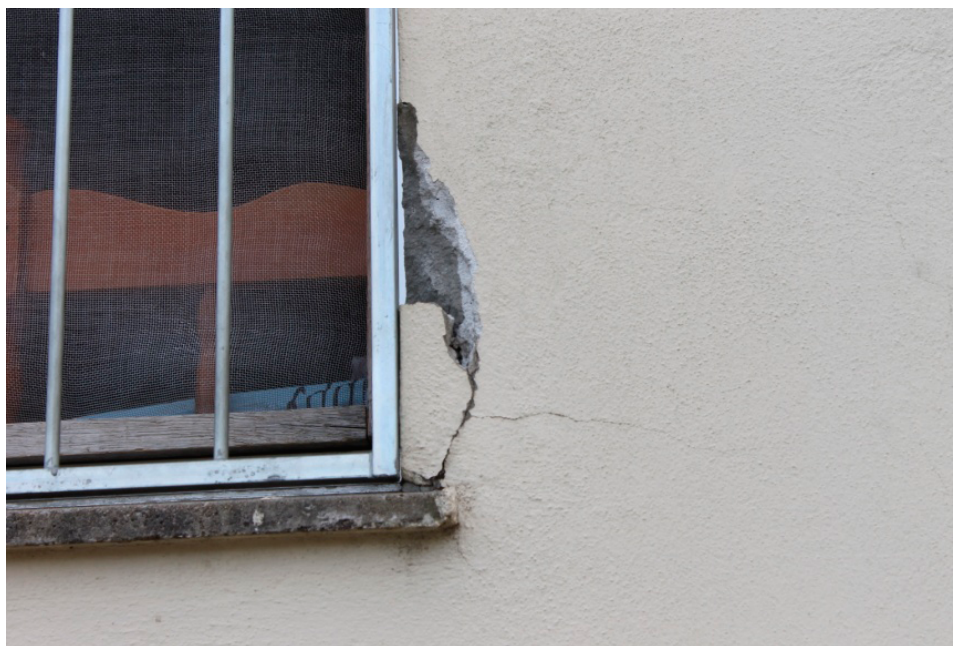
Figura 8. Descolamento devido instalação de grade
