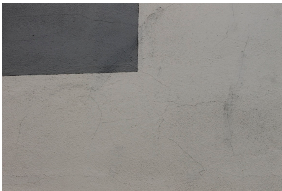
Figura 5. Fissuras mapeadas
