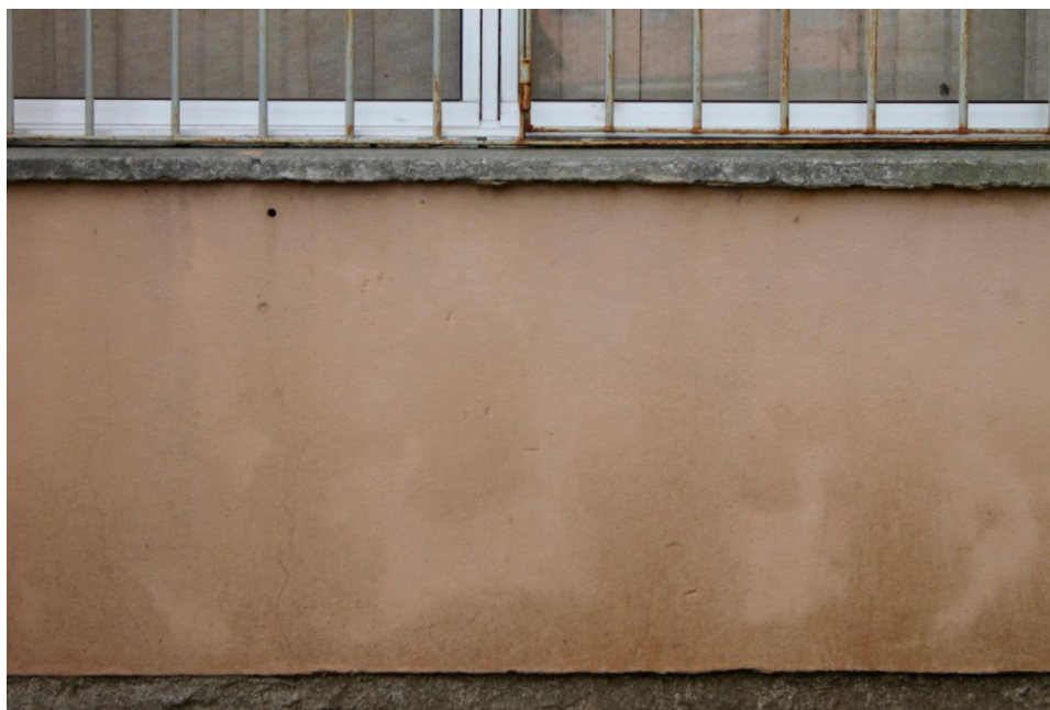
Figura 6. Umidade na parte inferior do revestimento
