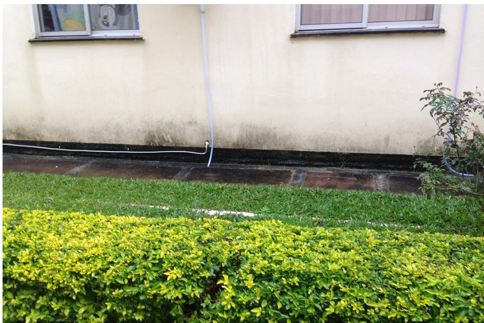
Figura 7. Umidade ascendente com deposição de sujeira
