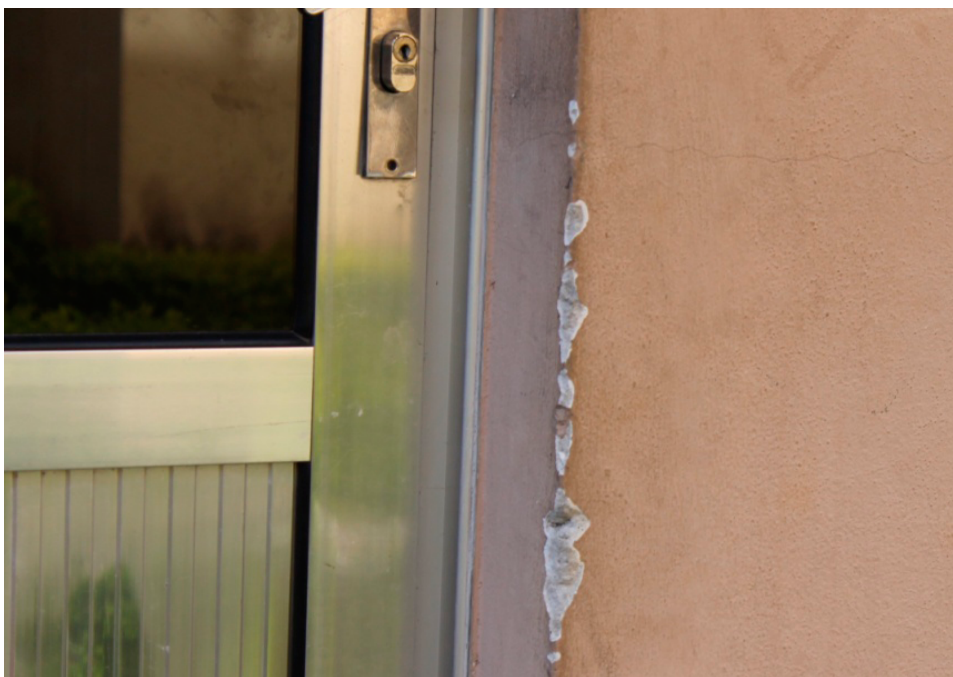
Figura 9. Descolamento devido a choques/impactos
