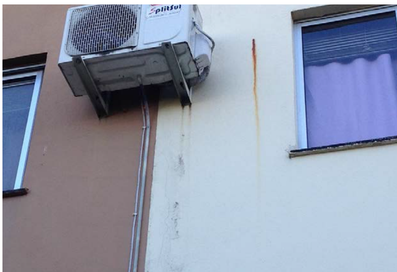
Figura 11. Detalhe do produto corrosivo na fachada
