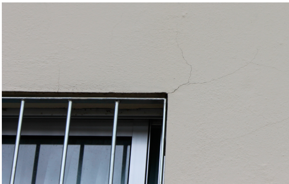
Figura 4. Fissura inclinada
