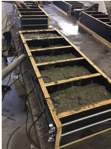
Figura 02 – Preenchimento das formas com concreto
