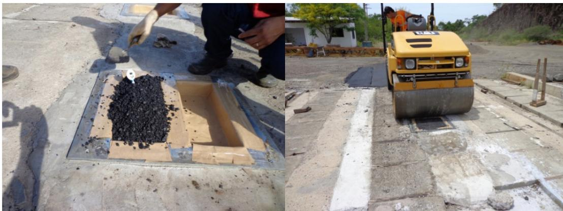
Figura 6 - Processo de compactação e controle de temperatura da mistura asfáltica.
