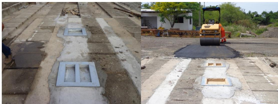
Figura 4 - Pista de moldagem construída na usina de asfalto para produção das placas de misturas asfálticas.
