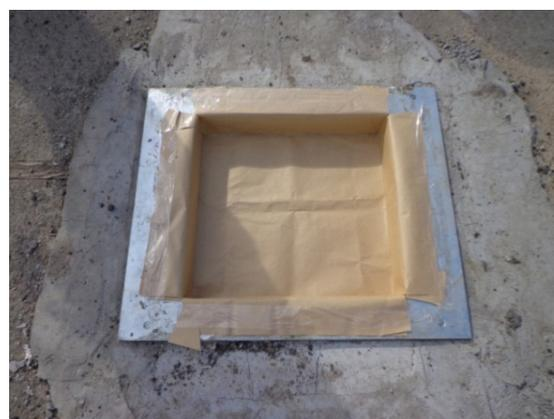
Figura 5 - Utilização de papel nos moldes metálicos.
