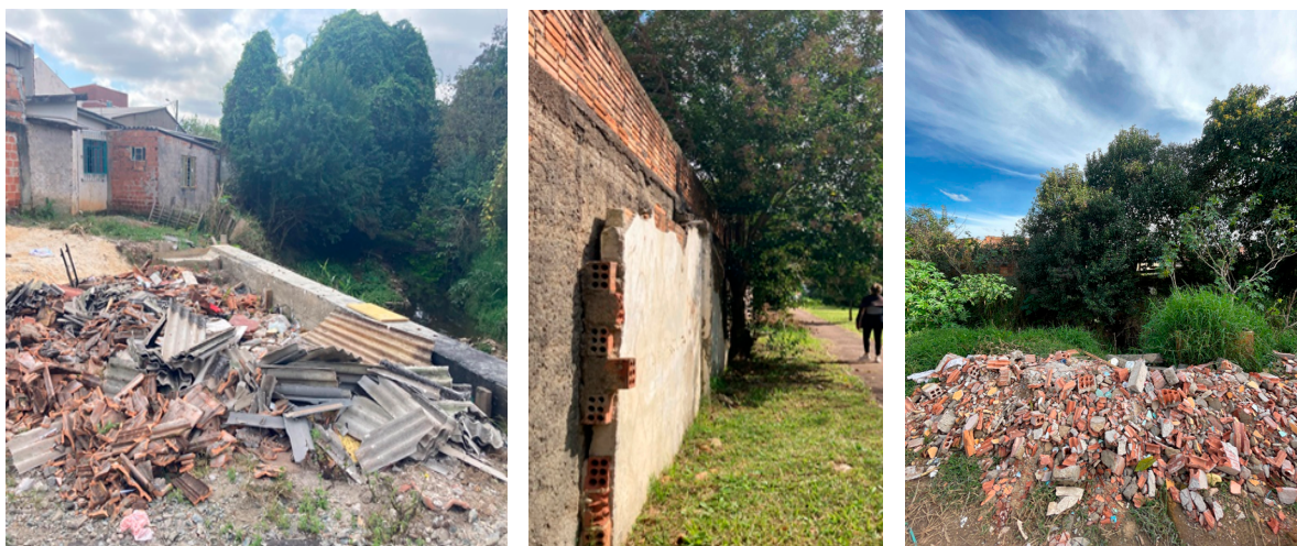
Figura 10. Restos de demolição das moradias situadas nas margens dos corpos hídricos
