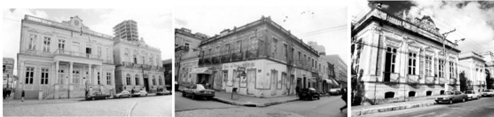
FIGURA 4 – Fotos dos Prédios do entorno da Praça Coronel Pedro Osório Fonte: Polidori (1999).
