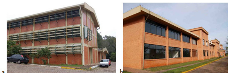
Figura 4 - a. Edifício G1, fachada Noroeste (NO); b. Edifício L1, fachada Nor-noroeste (NNO).
