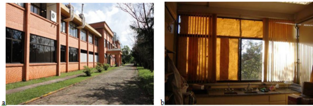
Figura 15 - Edifício L1: a. fachada NNO; b. sistema de proteção emergencial adotada.
