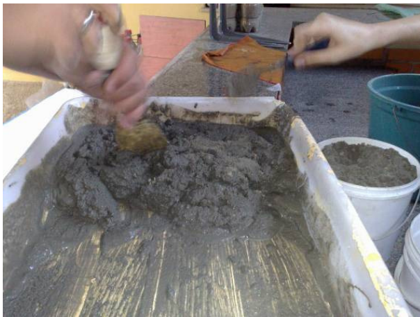
Figura 05 – Preparação da argamassa.
