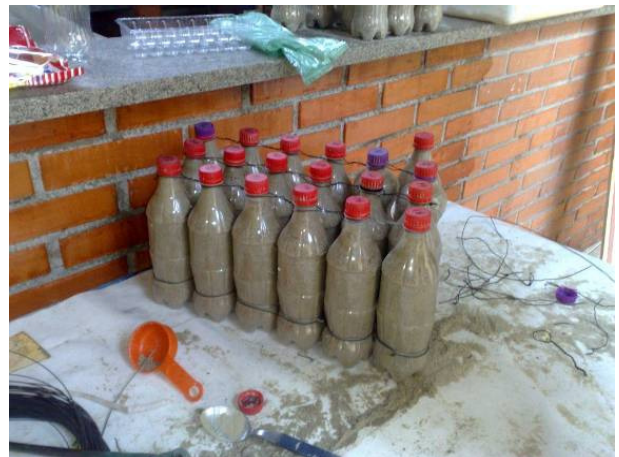
Figura 06 – Garrafas preenchidas e estruturadas com arame.
