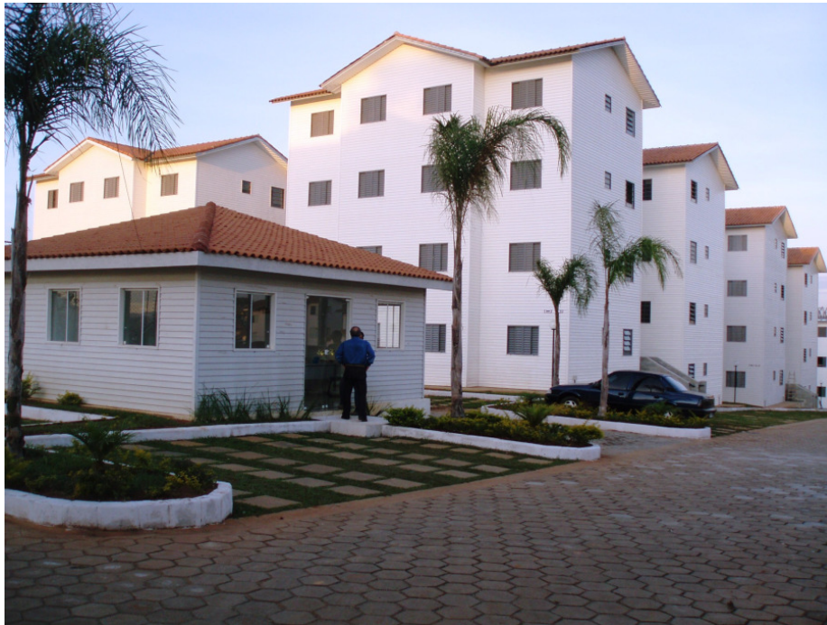
Figura 3 - Conjunto habitacional Colina das Pedras finalizado. Fonte: empresa Steel frame do Brasil Ltda.
