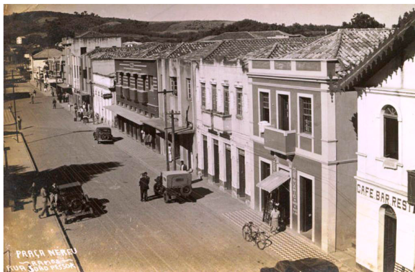
Figura 3. Rua João Pessoa - P. Nereu Ramos. Casa Londres à direita funcionava como Bar e Restaurante Gruta Baiana
