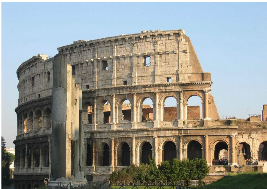
Figura 2 – Consolidação do Coliseu Romano – lateral esquerda (analogia).
