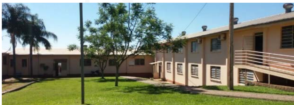
Figura 5. Vista Externa do edifício
