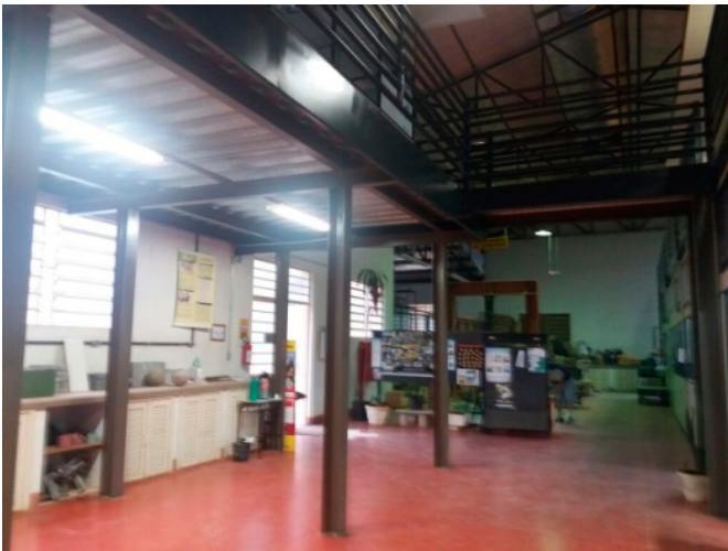
Figura 9. Vista da sustentação metálica do mezanino
