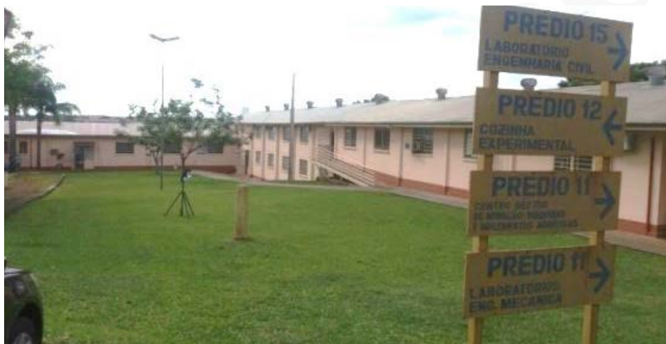
Figura 4. Vista externa do edifício
