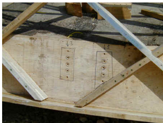
Figura 10: Colocação dos suportes
