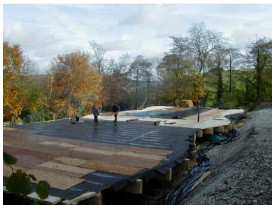
Figura 9: Piso é moldado no formato que a parte de baixo da estrutura deve adquirir quando montada
