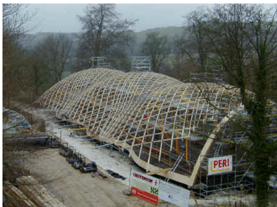
Figura 17: Moldagem em fase terminal
