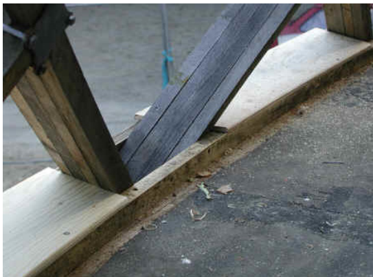
Figura 12: Conexão de borda pronta
