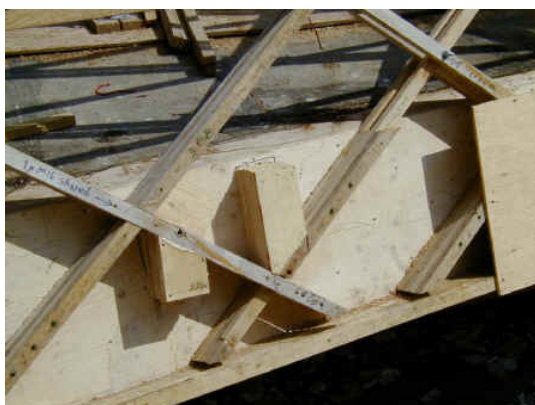
Figura 11: Detalhe da borda
